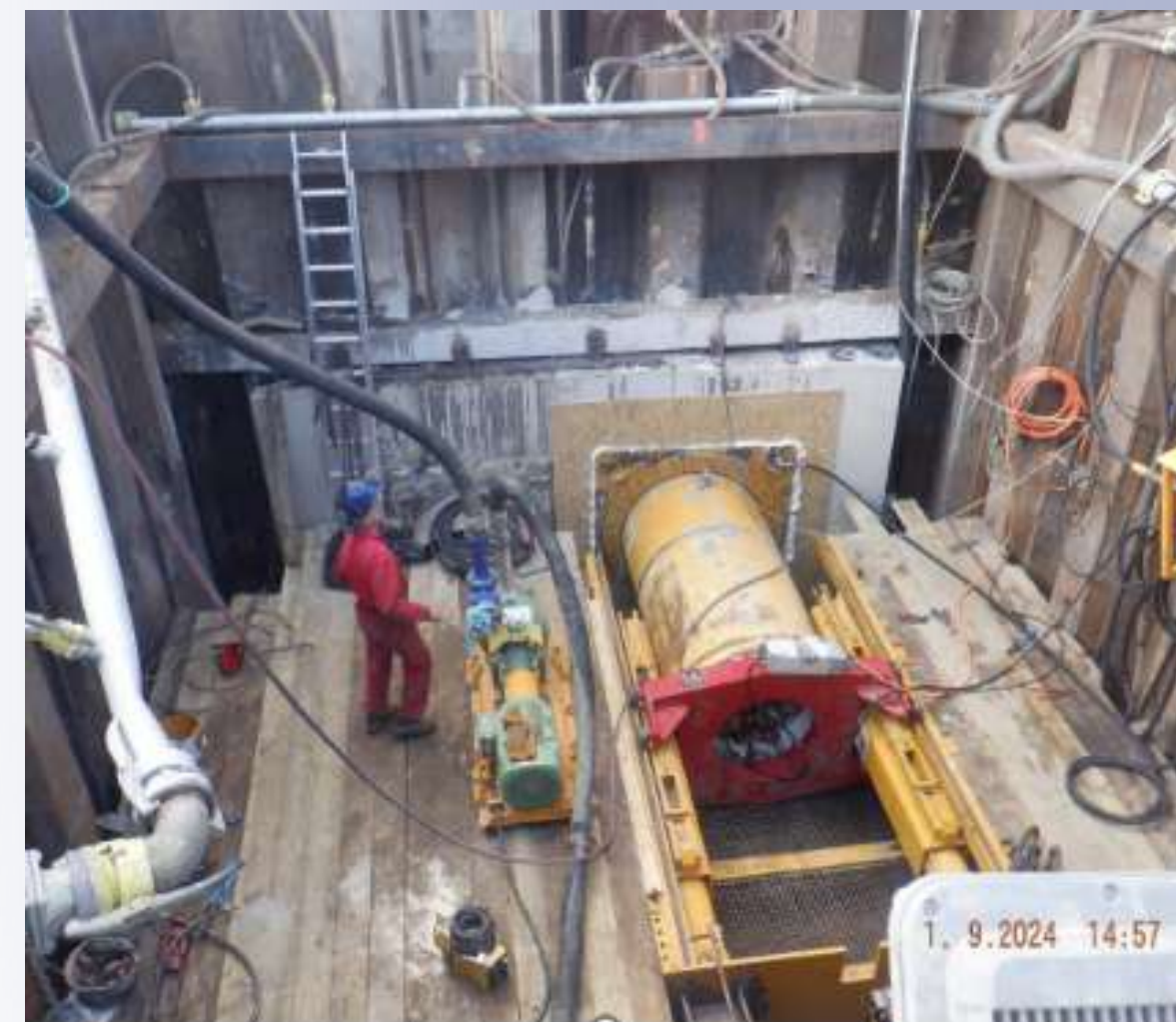
Siltumtīklu maģistrālē (SM) M-1 (Gaisa tilts) daļa virszemes tīkla pārbūvēta pazemes variantā, pirmo reizi Latvijā izmantojot caurdures tehnoloģiju
